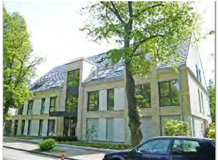
Objekt (Ansicht Strassenseite)
